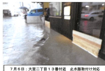
7月6日：大宮二丁目13番付近 止水版取付け対応
